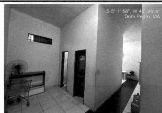
FOTO 04 - ACESSO AOS BANHEIROS
